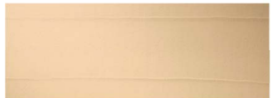
鏝波(コテナみ)仕上げ
